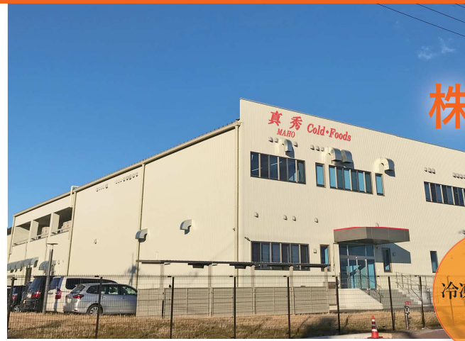
冷凍米飯の一貫生産ラインおよび冷凍保管設備を持つ社屋
